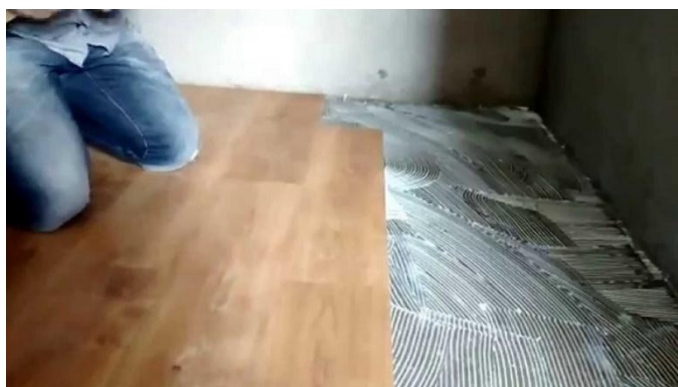
Figura 10: aplicação de cola para piso vinílico
