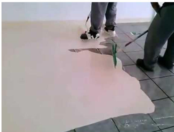
Figura 09: aplicação da massa autonivelante
